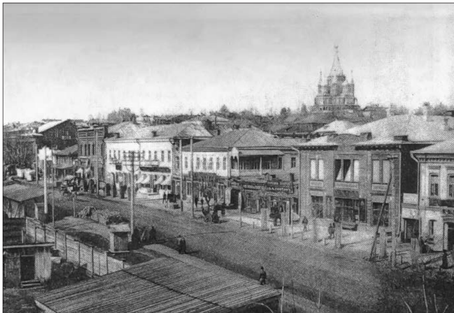
Купеческие дома на ул. Базарной (Горького). 1890-е гг. Фото из архива ВООПИК
