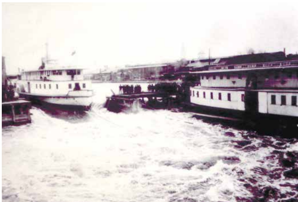
5. Спуск готовых пароходов с судовой верфи Воткинского завода в р. Вотку для дальнейшего сплава на р. Каму. Начало XX в. Историческая экспозиция БУК УР «Национальный музей УР им. К.Герда»
