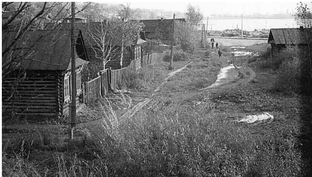
1. Переулок Безымянный (ныне ул. Безымянная) в районе старой Колтомы. Сейчас переулок застроен современными домами (из фондов НМ УР им. К. Герда). По публикации краеведа С.Н. Селивановского [Селивановский 2014: фото 333]
