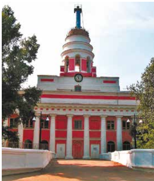
6. Фасад Главного корпуса оружейного завода. 2017 г. Фото автора
