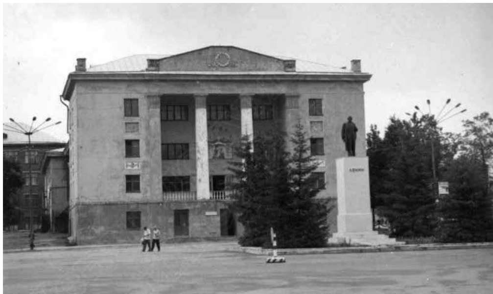
1. Здание Дома культуры им. В.И. Ленина на Площади им. павших за революцию борцов. Воткинск. 2003 г. Коллекция фотодокументов ЦГА УР
