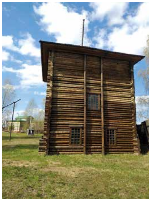
1. Александровская рассолоподъемная башня. Соликамск. 2019 г. Фото автора
